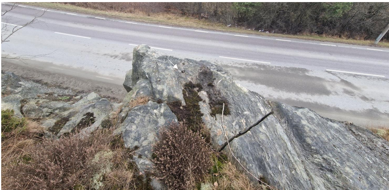
Figur 11 Bergslänt 4, vy från ovanifrån släntrönen. Äldre dubb markerad i med vit pil.
